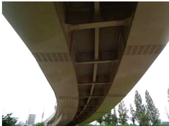
거더외부, 바닥판하면 전경
